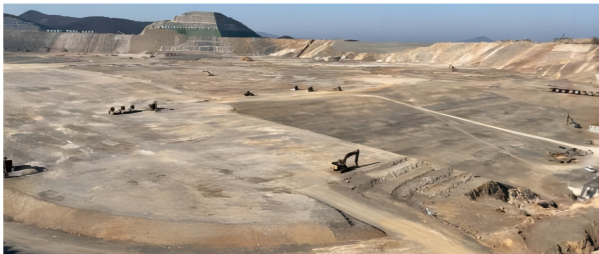
© 国网新源公司江苏句容电站上库施工现场
