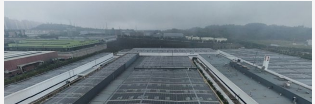
光伏发电项目
