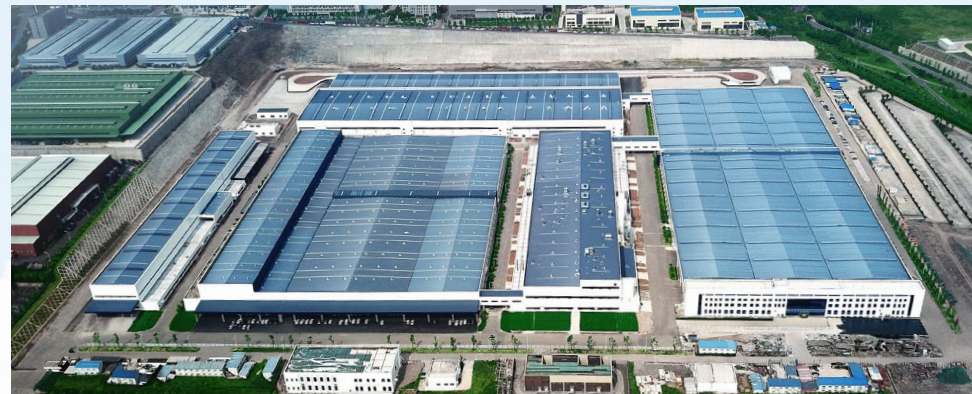
智慧工厂光伏电站
