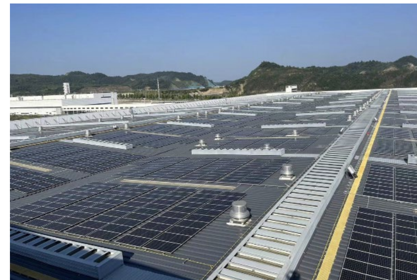
仓库屋顶铺设光伏
