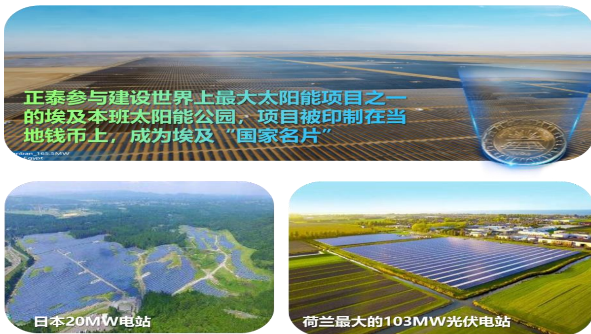
图 14：全球建成多座地面光伏电站项目
