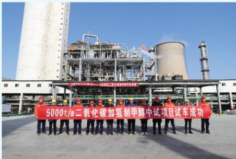
面向二氧化碳资源化利用技术需求，西南院联合鲁西集团攻关“二氧化碳高效制甲醇”项目。项目研发出高效催化剂和全流程工艺，设计建成5,000吨/年二氧化碳加氢制甲醇工业化试验装置并通过现场考核。完成10万吨/年二氧化碳加氢制甲醇工艺包，为产业化示范奠定坚实基础。“低能耗两段式二氧化碳加氢制甲醇技术”处于国际先进水平，其中催化剂性能达到国际领先水平。该项目具有自主知识产权、技术成熟度高的二氧化碳资源化利用技术，结合碳捕集和可再生能源制氢技术，可提供碳资源利用综合技术解决方案。
