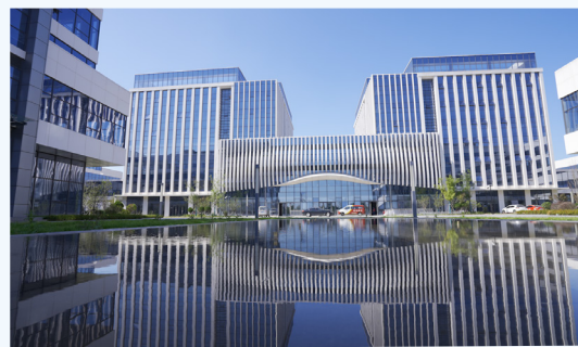
青岛空港综合保税区服务中心项目
