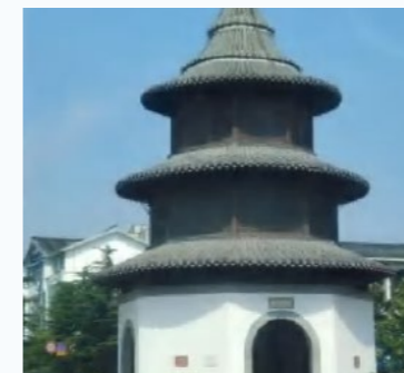
图. 扬州文昌阁修缮项目
