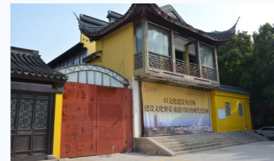
图. 常州天宁禅寺检测、修缮项目
