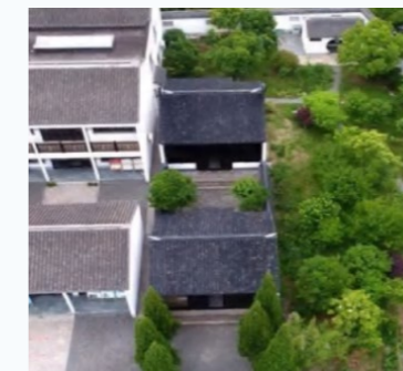
图. 李公仆旧居古建筑首次检测项目
