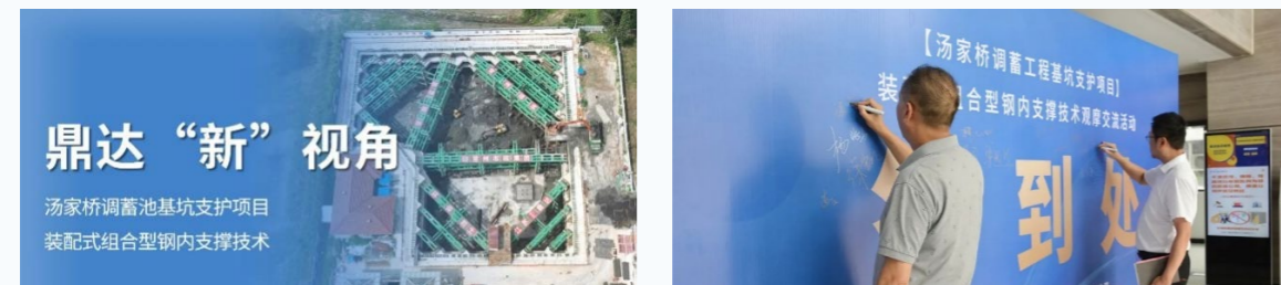
图. 汤家桥调蓄池基坑支护项目
