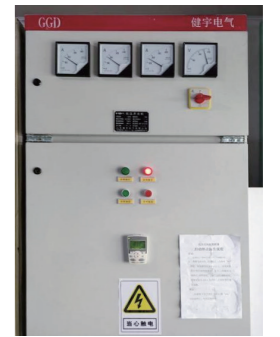
▲ 电机加装变频器设备
