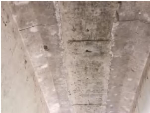
蒙西湾大桥湿接缝锈胀露筋
