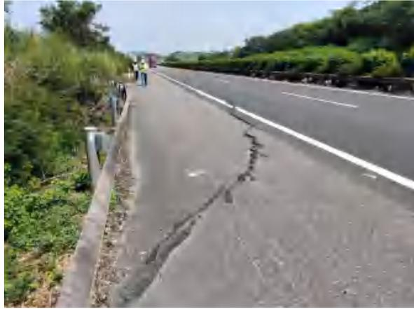
K708+100-K708+380 段填方段滑坡
