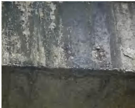
皇劳小桥 L1-1#空心板锈胀露筋
