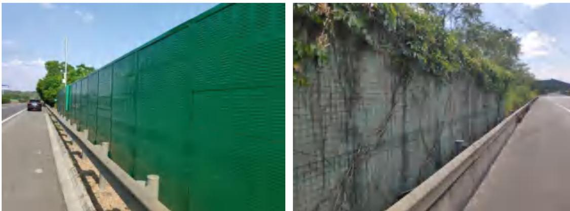
经现场踏勘，现有南百高速公路路中心线 200m 范围内声环境敏感点不多，主要分布在南宁境内，噪声污染源主要来自于居民的生活噪声和既有道路交通噪声，敏感区内房屋主要为砖瓦房和砖混结构房屋；大部分声环境敏感点如浪湾、枯龙、那莫、王官等已设有声屏障降噪措施，声屏障型式主要为百叶窗式彩钢板声屏障和混凝土墙声屏障，其中百叶窗式彩钢板声屏障屏体可拆除后重复利用。
