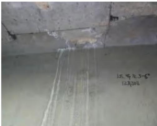
达咿河大桥 L5-1#T 梁纵向裂缝
