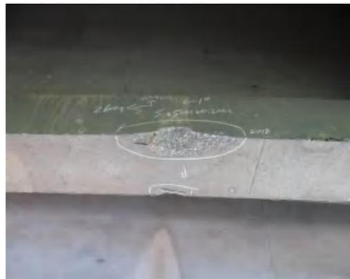
达咿河大桥 L6-1#T 梁破损露筋
