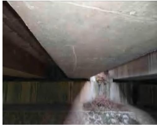
达寒河大桥 R1-1#梁底纵向裂缝
