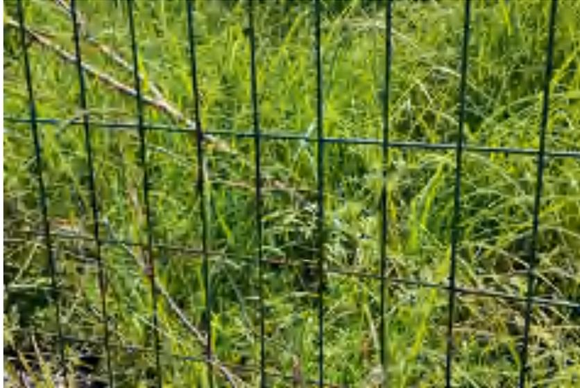
图 4.9-4 现状焊接网隔离栅，防腐层脱离
