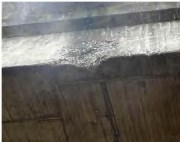
皇劳小桥 R1-1#空心板梁剥落、刚蹭
