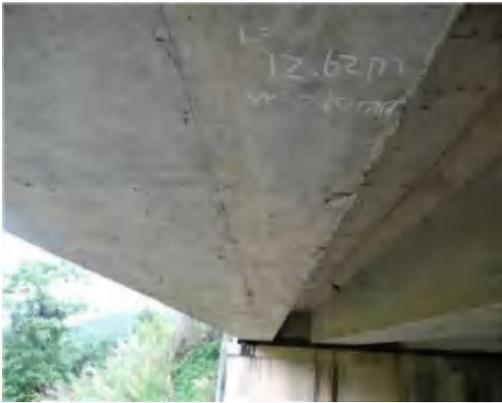
大林中桥 R1-7#小箱梁梁底纵向裂缝
