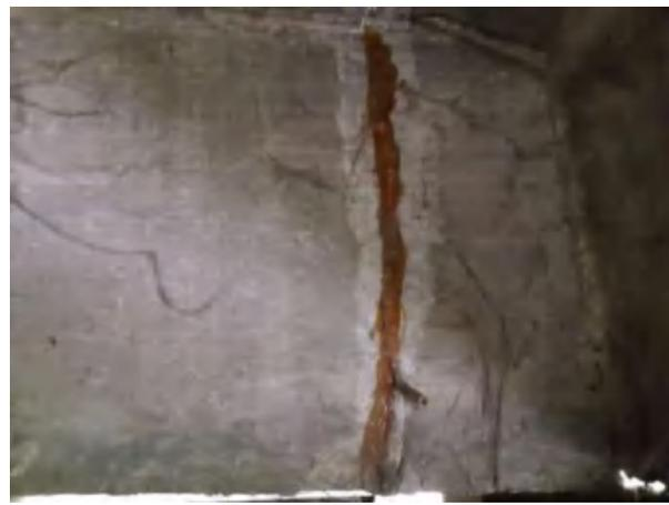
那福大桥横隔板竖向裂缝 21
