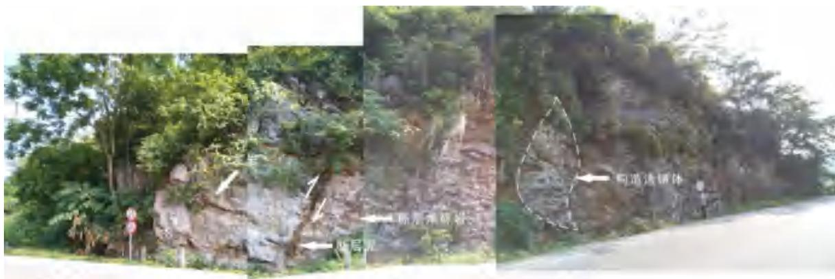
下三叠统（T1）灰岩区，受那斜-永安断裂影响发育断层泥、断层角砾岩及构造透镜体，岩体破碎
