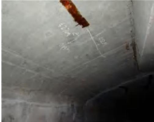
镇流右江大桥 R2-1#箱内顶板纵缝
