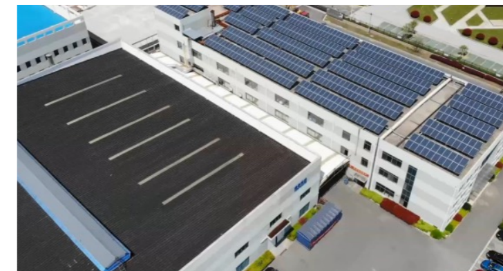
分布式屋顶光伏项目
