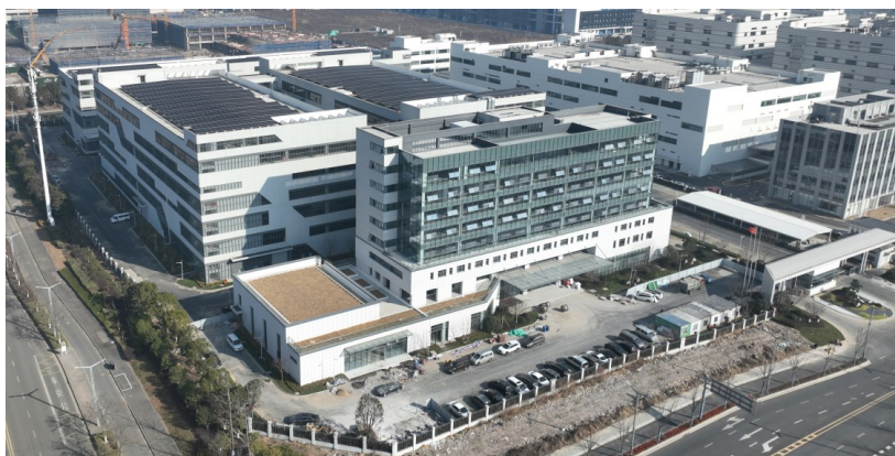
图注：苏州盛弘屋顶铺设光伏
