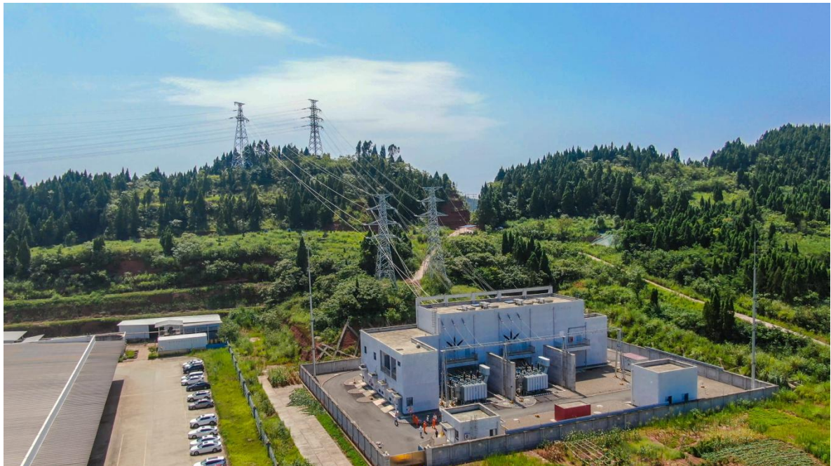
220 千伏同盟站 110 千伏配套出线工程
