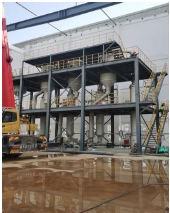
三效蒸发器系统 注解：用于水和固体分离
