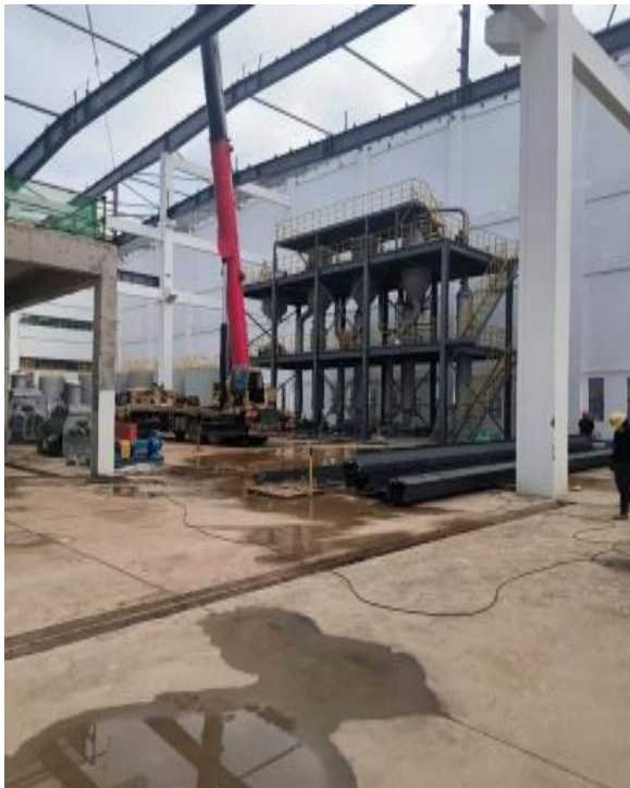
三效蒸发器系统 注解：用于水和固体分离
