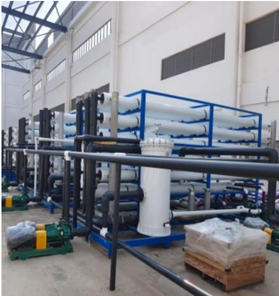
MBR 超滤膜件 注解：用于反应后废水过滤
