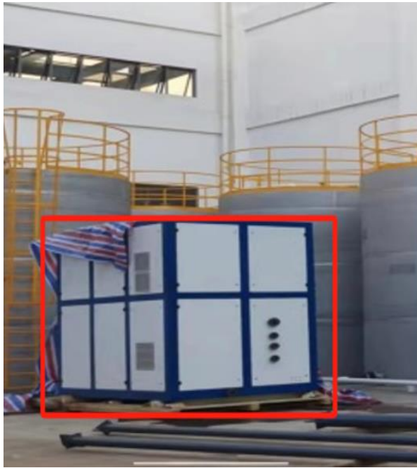
高 COD 废液处理设施 注解：用于处理有机物过高的废水
