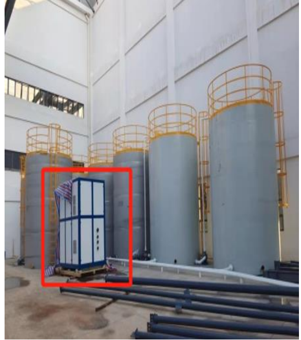
高 COD 废液处理设施 注解：用于处理有机物过高的废水
